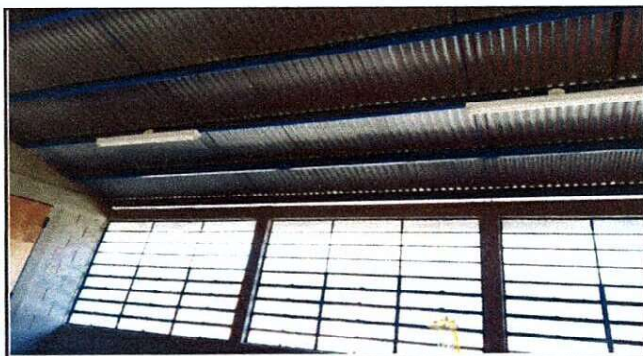
Foto 3: Reparación e instalación de sistema eléctrico
