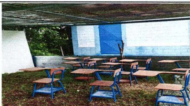
Foto 1: Mejoramiento de la estructura del techo en mal estado
