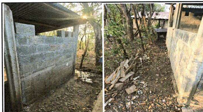
Foto 4: Ampliación de pared de cocina
