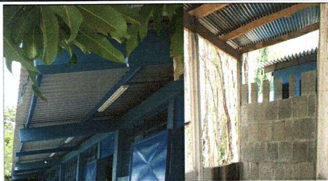
Foto 2: Reparación de sistema eléctrico
