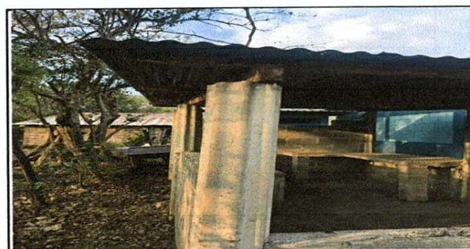
Foto 6: Sustitución de techo de cocina
