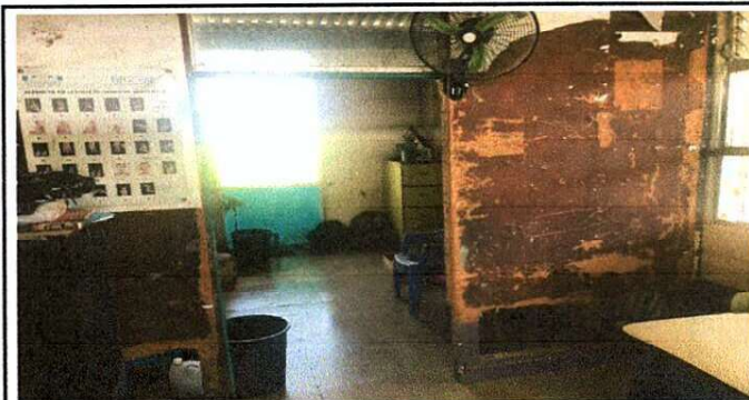
Foto 4: Sustrucción de Divisiones en Dirección de block.
