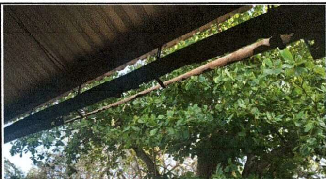
Foto1: Sustrucción de (11 canales de caída de agua) .
