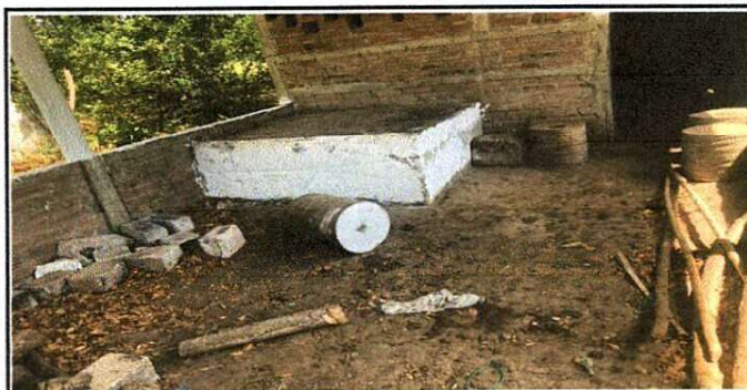
Foto 6: Sustrucción de piso a cocina Escolar.
