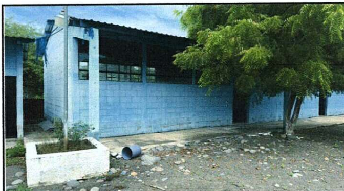
Foto 4: SUSTITUCIÓN DE PINTURA EN MUROS DE AULAS.
