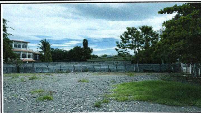
Foto 2: SUSTITUCIÓN DE MURO PERIMETRAL DE LÁMINA POR MURO TIPO BARDA LADO DERECHO DE LA ENTRADA.
