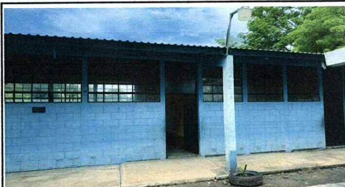
Foto 3: SUSTITUCIÓN DE PINTURA EN MUROS DE AULAS.
