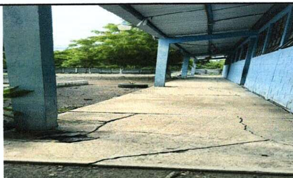
Foto 6: SUSTITUCIÓN DE PISO DE CONCRETO.
