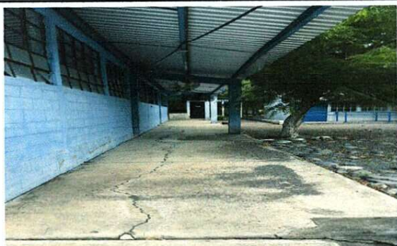
Foto 5: SUSTITUCIÓN DE PISO DE CONCRETO.
