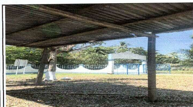
Foto 3: Sustitución de columnas de madera por concreto.
