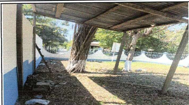
Foto 1: Reparación de piso torta de concreto.
