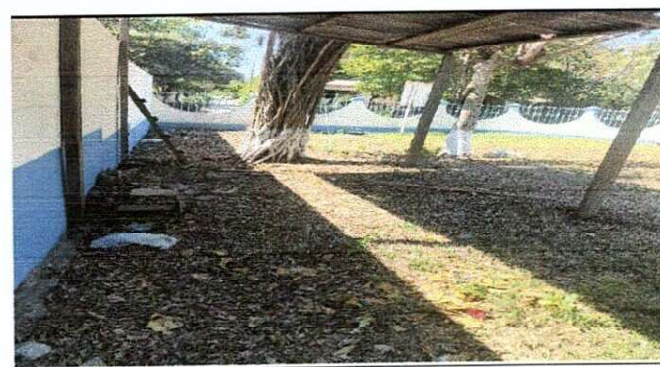
Foto 6: Ampliación de paredes de block
