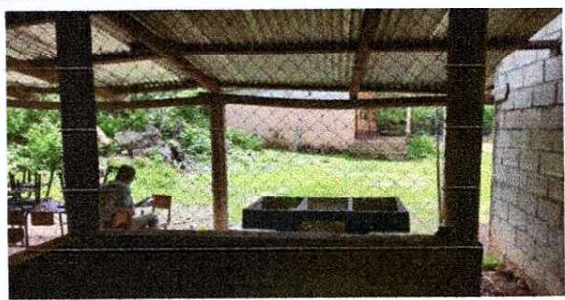
Foto 1: Paredes de aulas para ampliar con block y columnas de concreto reforzadas con varilla de hierro
