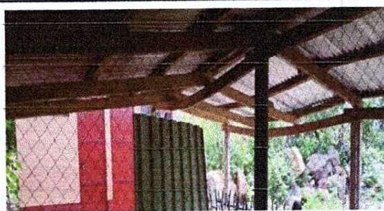
Foto 4: Estructura de soporte de madera dañada y torcida para sustituir por estructura galvanizada y lámina dañada y de mala calidad a sustituir por lámina troquelada calibre 26 en aulas.
