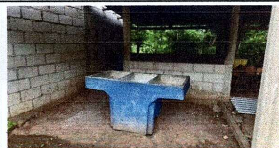
Foto 9: Torta rústica en area de pila dañada a mejorar con torta lisa de cemento en area anexa de cocina.
