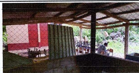
Foto 3: Areas para instalación de puertas y ventanas metálicas en aulas
