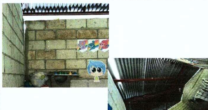
Foto1: MODULO AULA: elaboracion de 3 columnas de 20x15 con zapata. Sustitucion de lamina dañada por lamina troquelada aluzin calibre 26 sustitucion de capote en mal estado, para lamina troquelada y sustitucion
