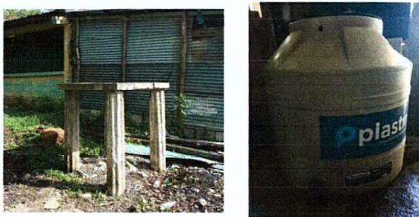
Foto 5: MODULO SANITARIO: Reparacion e instalacion de lavamanos ceramico, sustitucion de deposito de agua para sanitarios 1,100lts.
