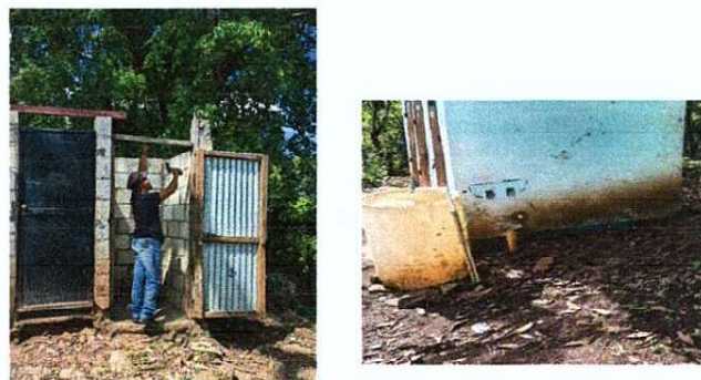
Foto 4: MODULO SANITARIO: Instalacion de sanitario y accesorios, instalacion de puerta metalica para sanitario, repello y cerrido de paredes internas y externas, reparacion de pared de muros de sanitario sustitucion de torta lisa de cemento a piso ceramico, reparacion de lavamanos ceramico.
