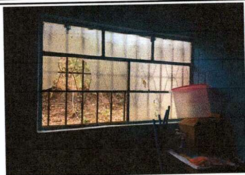
Foto 1: CAMBIO DE VENTANAS
