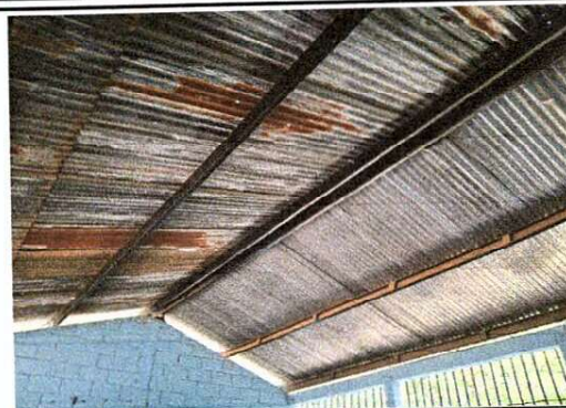
Foto 2: SUSTITUCION DE LAMINA EN MAL ESTADO POR LAMINA TROQUELADA Y COSTANERA GALVANIZADA
