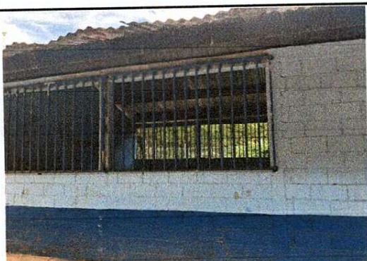
Foto 3: CAMBIO DE BALCONES EN MAL ESTADO
