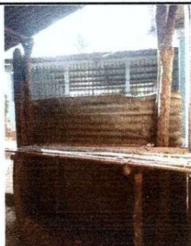
Foto 3: SUSTITUCION DE MESA DE CONCRETO
