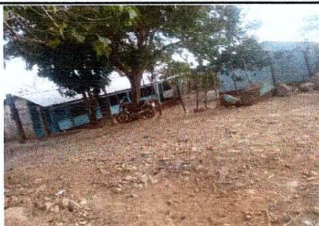
Foto 5: CIRCULADO DE MURO PERIMETRAL EN PARTE DE ENFRENT
