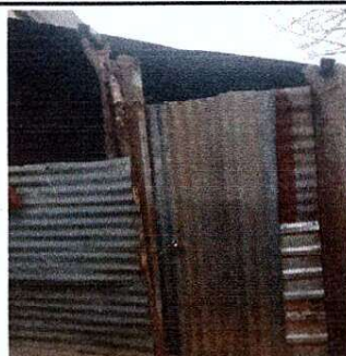
Foto 6: INSTALACION DE PUERTA METALICA
