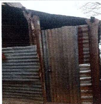
Foto 1: SUSTITUCION DE PAREDES COCINA
