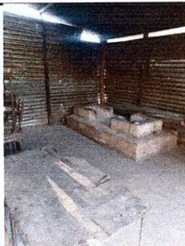
Foto 2: SUSTITUCION DE PLANCHA DE COCINA
