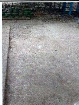
Foto 4: ENTORTADO DE CEMENTO EN PATIO
