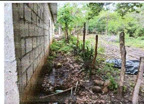
Foto 6: Límite junto a la construcción.
