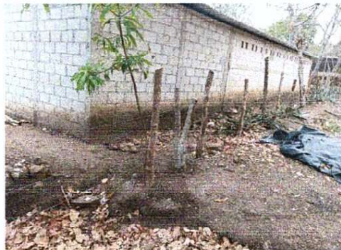
Foto 4: Límite junto a la construcción.
