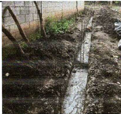
Foto 2: Reparación de muro perimetral con malla galvanizada y tubo HG.
