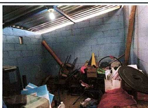
FOTO 4: INSTALACION DE ENERGIA ELECTRICA
