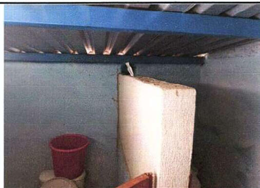
Foto 2: SUSTITUCION DE LAMINA EN MAL ESTADO POR LAMINA TROQUELADA E IMPLEMENTACION DE AZULEJO Y PISO ANTIDESLIZANTE
