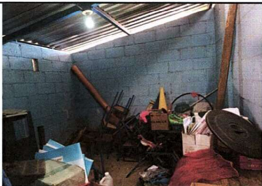
Foto 1: MANTENIMIENTO DE PAREDES , INSTALACION DE PLANCHA PARA COCINAR Y MESA DE CONCRETO, PILA
