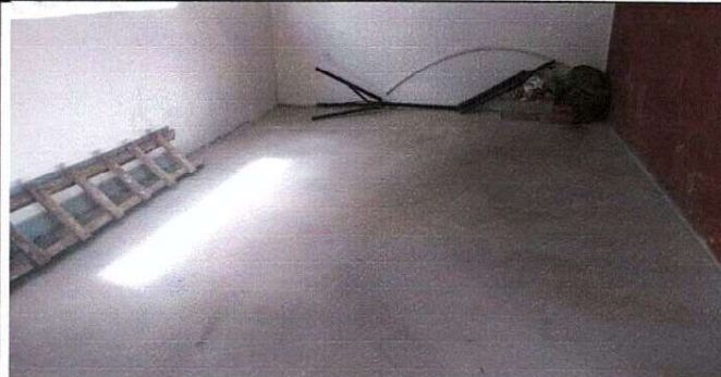
Foto 6: SUSTITUCION DE LOSA
