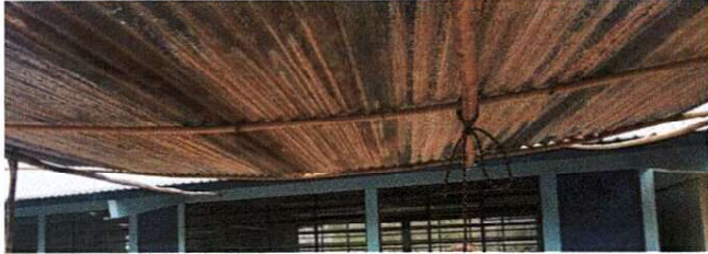
Foto 1: MEJORAMIENTO DE TECHADO Y ENTORTADO DE PATIO
