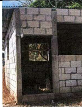
Foto 2: SUSTITUCION DE TECHO, ENTORTADO
