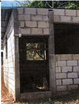
Foto 3: IMPLEMENTACION DE PLANCHA PARA COCINA, MESA DE CONCRETO
