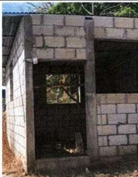
Foto 5: IMPLEMENTACION DE UNA PUERTA METALICA EN COCINA
