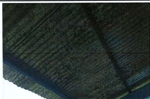
Sustitucion de lamina acanalada por lamina troquelada
