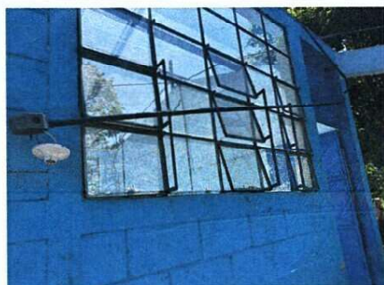
Sustitucion de ventanas
