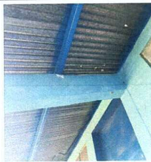
Lijado y pintura de soporte de metal
