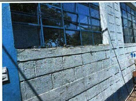
Sustitucion de ventanas
