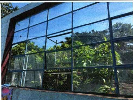
Sustitucion de ventanas de metal por ventanas de pvc
