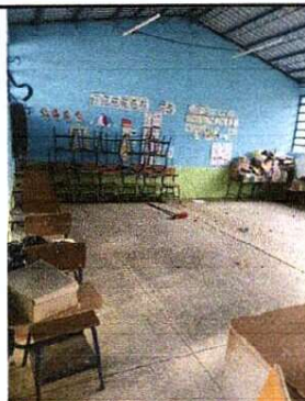
Foto 4: SUSTITUCION DE PISO EN AULAS
