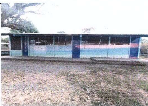
Foto 5: ENTORTADO DE PATIO Y TECHADO
