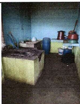
Foto 3: SUSTITUCION DE PLANCHA Y PISO DE COCINA
