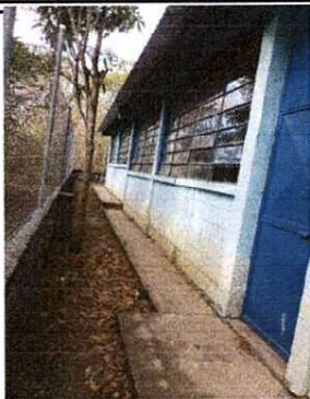
Foto 1: SUSTITUCION DE MALLA METALICA
