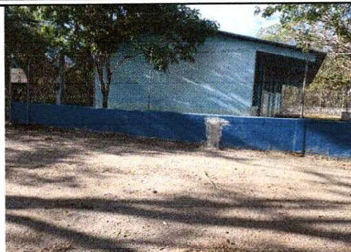
Foto 2: SUSTITUCION DE MALLA
