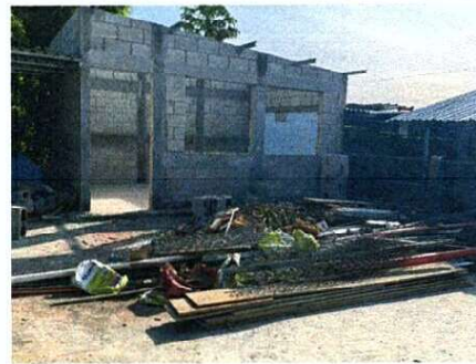
Foto 4: Sustitución de maya por ventanas y fabricacion e Instalacion de Balcones.
