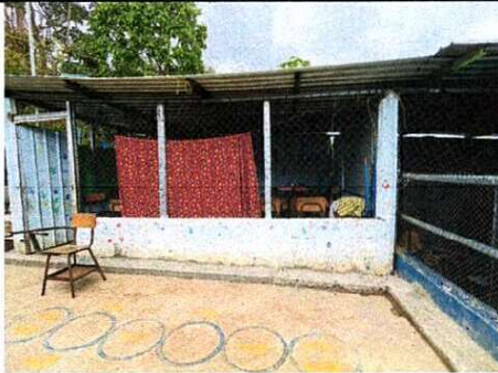
Foto 3: Sustición de maya por fabricacion e Instalacion de Ventanas Corredisas de Metal con Vidrio.
