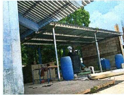
Foto 2: Sustitución de laminas y pleibol por instacion y estructura metalica.
