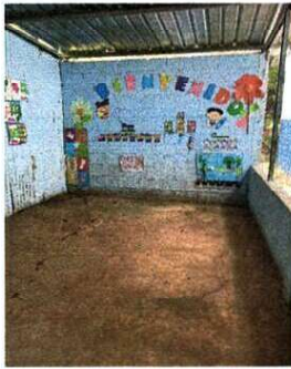
Foto1: Sustitución de piso en aulas que tienen torta.
