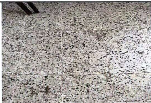
Foto 3: CAMBIO DE PISO
