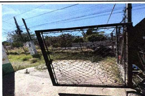
Foto 8: SUSTITUCIÓN DE PORTON PRINCIPAL
