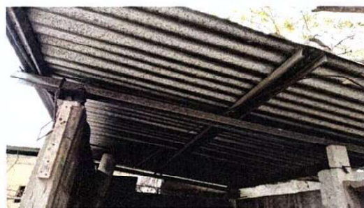
Foto 6: SUSTITUCIÓN DE LÁMINA
