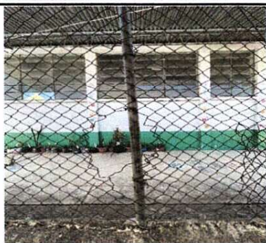
Foto 1: MEJORAMIENTO DEL MURO PERIMETRAL
