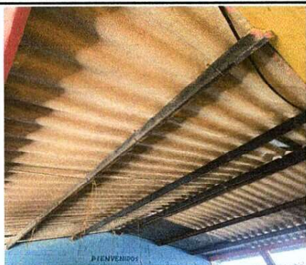
Foto 1: Techo y estructura
