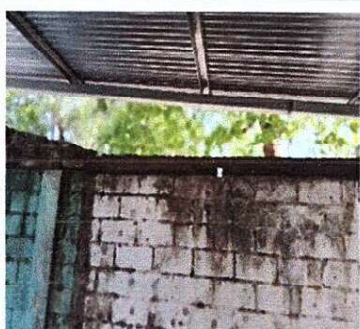
Foto 2: Reconstrucciones, repellos, cernidos y pintura de 3 paredes por entrada de aire, polvo y agua.
