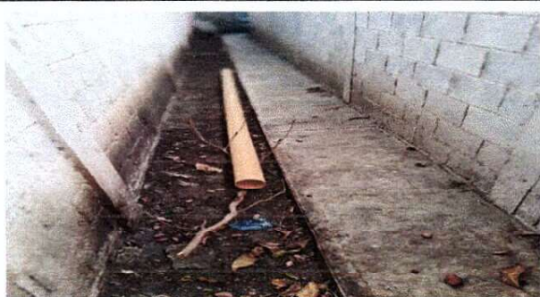
Foto 6: Sustrucción de drenaje por tuos de PVC
