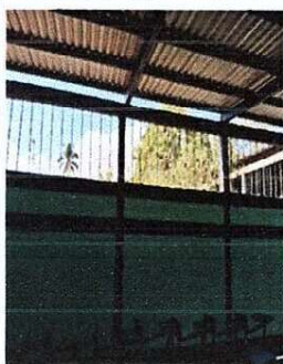
Foto 2: Reconstrucciones, repellos, cernidos y pintura de 3 paredes por entrada de aire, polvo y agua.
