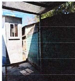
Foto 1: Repello de paredes y reposición de pared de madera por blok
