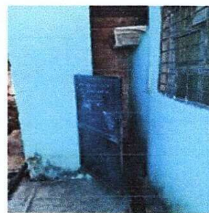
Foto 1: Repello de paredes y reposición de pared de madera por blok
