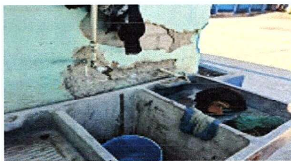
Foto 7: Reposición de 2 pilas
