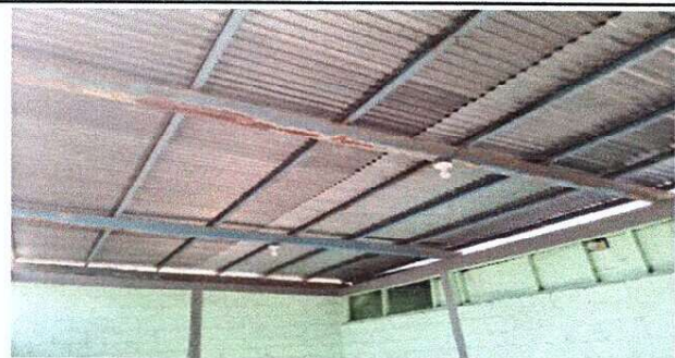
Foto 4: Desinstalación, reparación e instalacion de estructura metálica y lámina.
