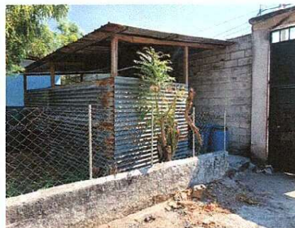
Foto 2: SE CONTINUARA PARED DE BLOCK Y COLUMNAS EN COCINA
