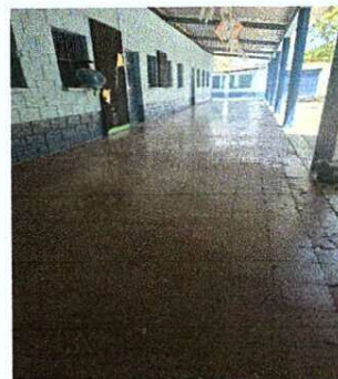
Foto 2: piso del primer edificio
