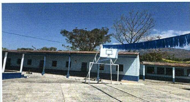
Foto1: Techo Segundo Edificio
