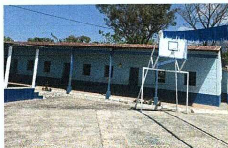
Foto 4: Techo segundo edificio
