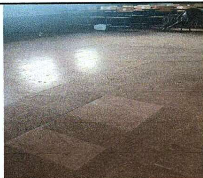
Foto 6: Piso aulas segundo edificio
