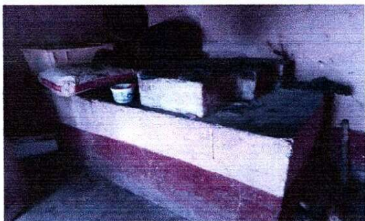
Foto 1: Sustitución de ornillas por plancha de metal con chimenea
