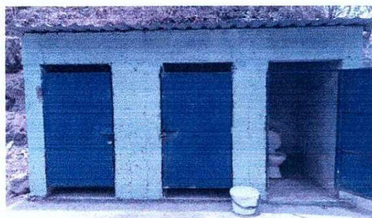
Foto 6: Mantemimiento en puertas
