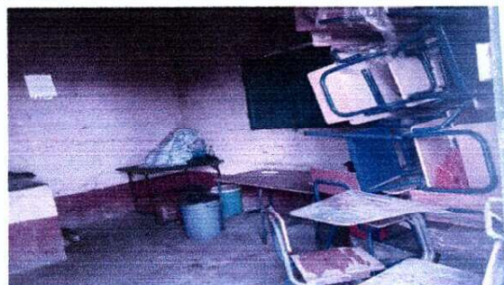
Foto 4: Pintura en muros exteriores e interiores
