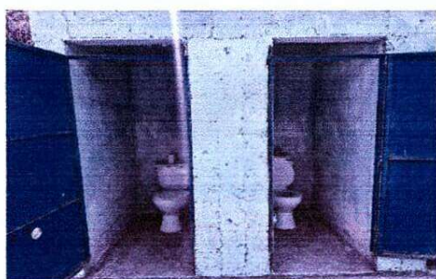
Foto 5: Mejoramiento con asulejo y Sustitución de Torta por Piso ceramico
