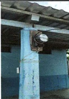
Foto 3: REPARACIÓN DE SISTEMA ELÉCTRICO
