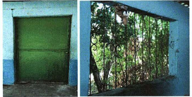
Foto 2: SUTITUCIÓN DE PUERTA Y VENTANA
