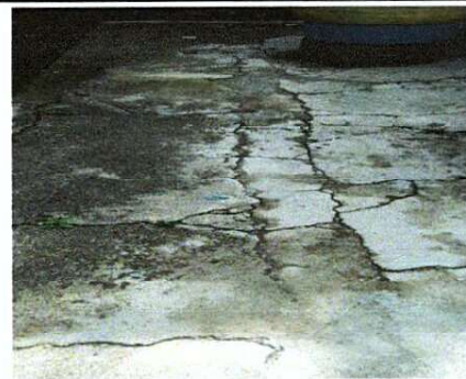
Foto 6: REPARACIÓN DE LOSA DE PATIO
