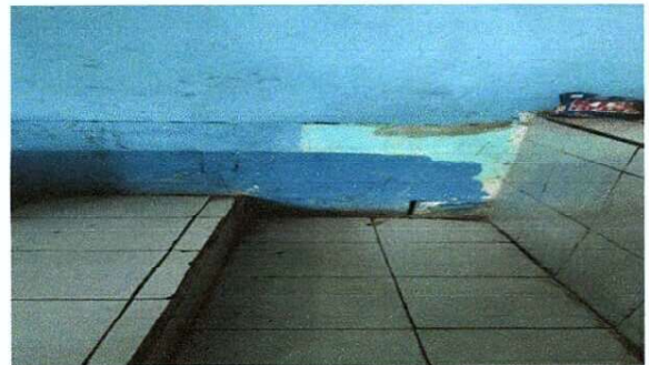
Foto 4: SUSTITUCIÓN DEL PISO
