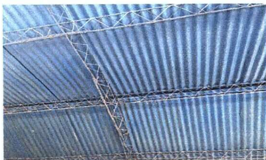
Foto 5: Sustitución de lamina por lamina troquelada calibre 26 del baño
