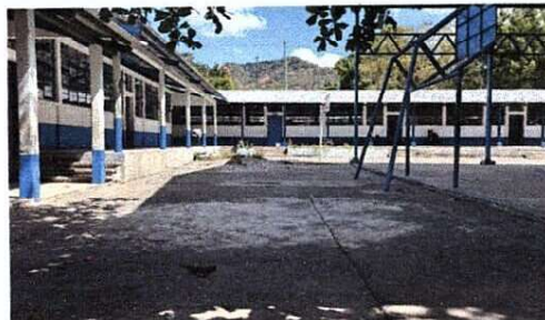
Foto 10: Reparación de plancha de concreto
