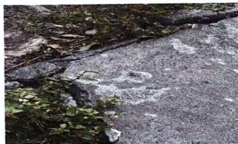
Foto 8: Reparación de plancha de concreto
