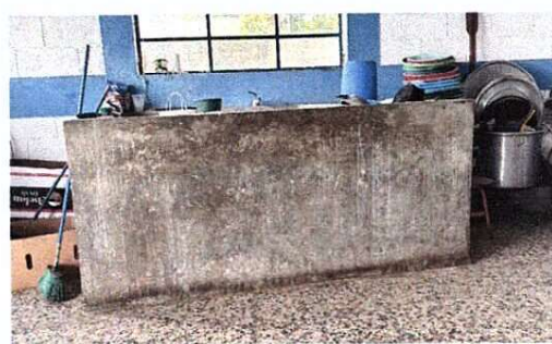
Foto 2: remozamiento y mejoramiento de pila
