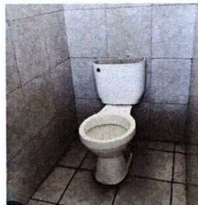
Foto 6: Sustitución de Inodoro
