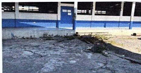
Foto 9: Reparación de plancha de concreto
