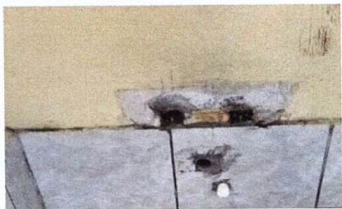
Foto 7: Sustitución de lavamanos
