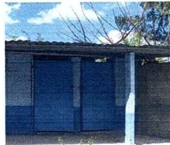
Foto 2: Sustitución de Puertas en los Baños
