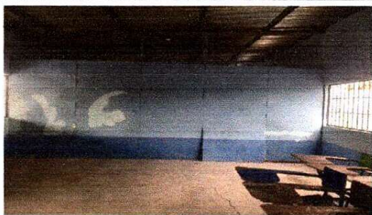
Foto 5: Reforzamiento de Pared
