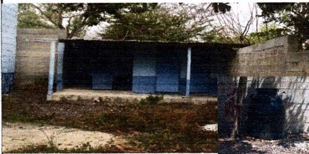
Foto 3: Sustitución de lámina por lámina troquelada aluzinc calibre 26, Sustitución de Estructura de madera por Estructura de Metal y terraza para la Instalación de Tinaco.
