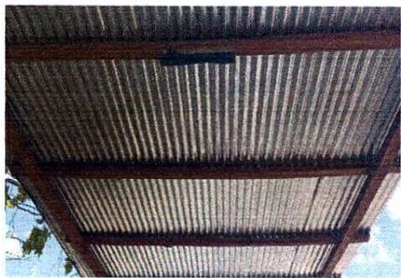
Foto 1: Sustitución de lámina por lámina troquelada aluzinc calibre 26, Sustitución de Estructura de madera por Estructura de Metal
