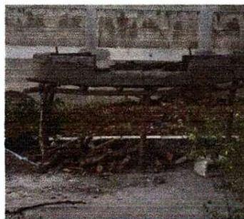
Foto 2: Mejoramiento de pared en Cocina
