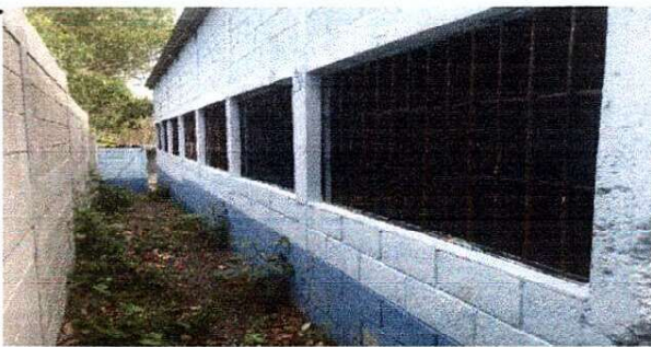
Foto 6: Fabricación e intalación de ventanas
