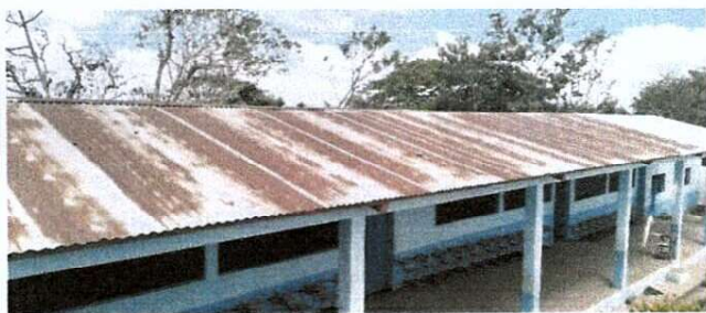
Foto 3: Cambio de Techo 1
