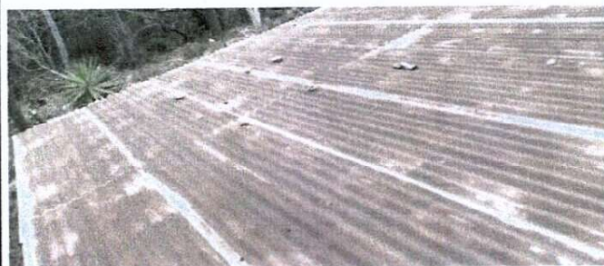
Foto 4: Cambio de Techo 2
