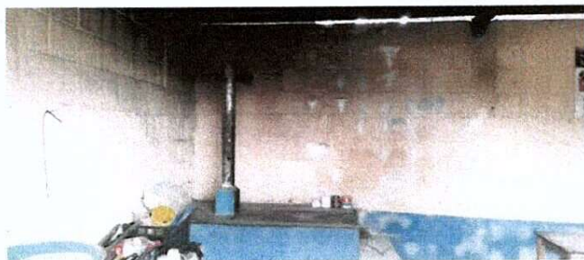
Foto1: Cambio Chimenea y ampliación
