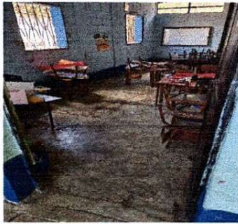
Foto1: Sustitución de Torta por Piso en la Bodiga que se utiliza como Aula
