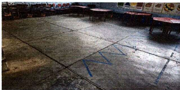
Foto1: Sustitución de Torta por Piso ( Cuatro Aluas )
