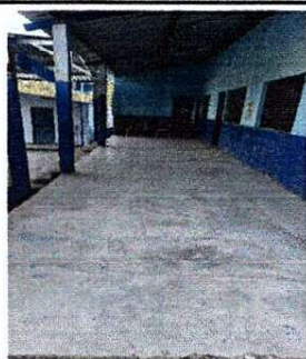
Foto 5: Sustitución de Torta por piso en los Corredores
