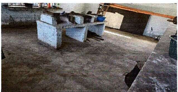
Foto 3: Sustitución de Torta por Piso de la Cocina
