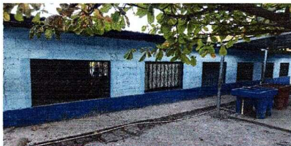
Foto 2: Fabricación e Instalación de Ventanas 12 ( Cuatro Aluas )
