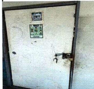
Sustitución de puerta de metal de módulo
