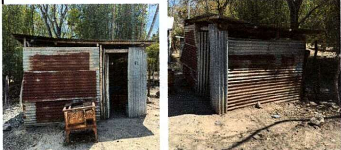
Mejoramiento de cocina: Sustitución de pared de lámina por block
