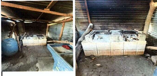
Sustitución de techo de madera por metal de cocina y Sustitución de piso de torta de concreto de cocina (más piso cerámico).
