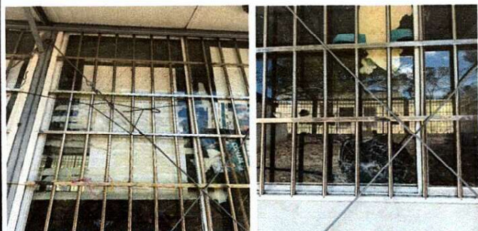
Sustitución de estructura de metal y cambio de vidrios de ventanas de módulo
