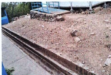
Mejoramiento y reparación de cuneta de concreto, mejoramiento de bordillo en muro de patio
