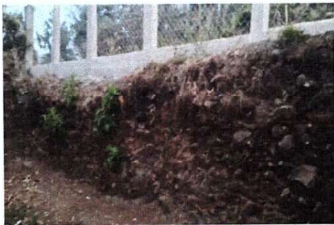
Reparación de muro de contención para evitar el derrumbe del muro perimetral sobre el módulo de párvulos.
