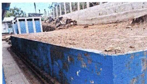
mejoramiento de losa de concreto de patio, mejoramiento de barandas de metal con malla galvanizada, recubrimiento sintético en patio.
