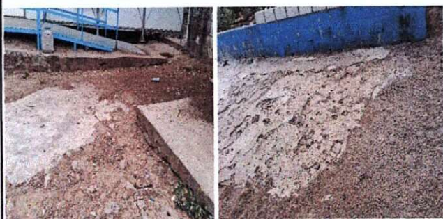
mejoramiento de losa de concreto de patio
