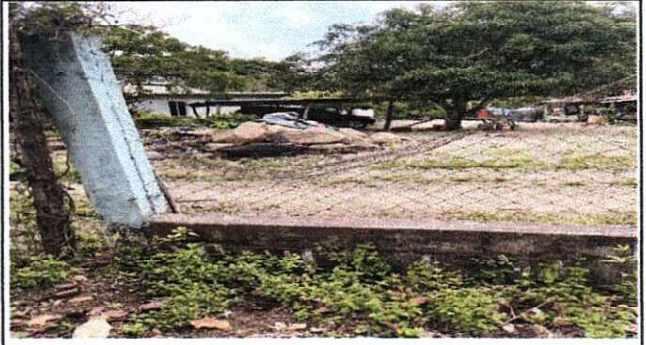
Foto 2: Continuación de muro perimetral
