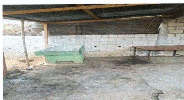
Foto 6: Mejoramiento de base de concreto para piso
