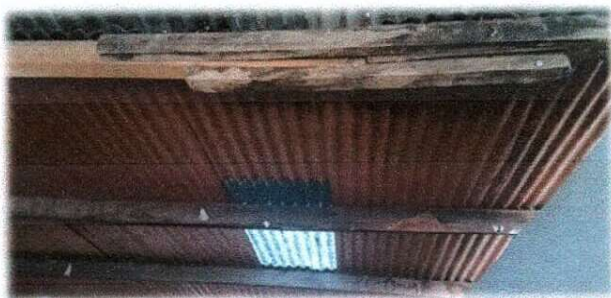
Foto 3: Mejoramiento de estructura de techo
