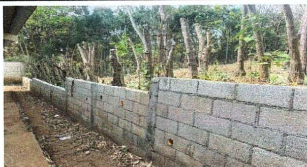
Foto 5: Mejoramiento de muro de block
