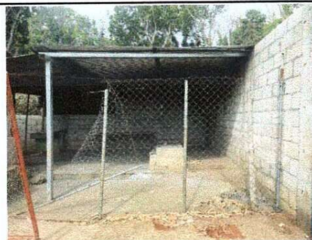
Foto 2: Mejoramiento de muro en cocina
