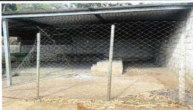
Foto 3: Fabricacion e instalacion de puerta y ventana de cocina de metal.
