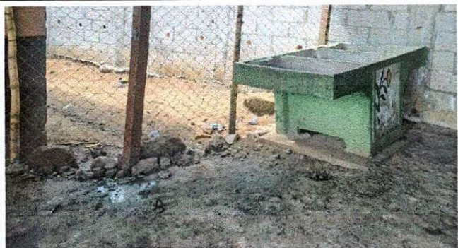
Foto1: mejoramiento de registro para drenaje
