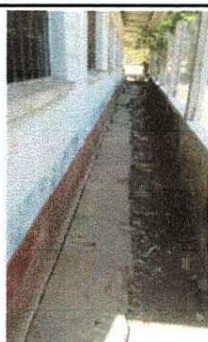
Foto 5: Reparación de banqueta
