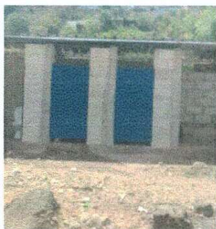
Foto1: Mejoramiento de piso antideslizante en servicio sanitario
