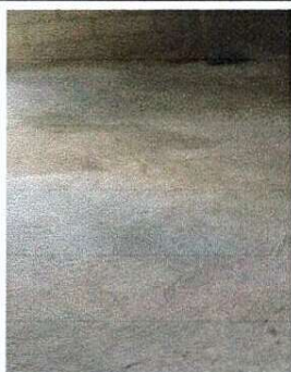
Foto 3: Mejoramiento de piso en cocina
