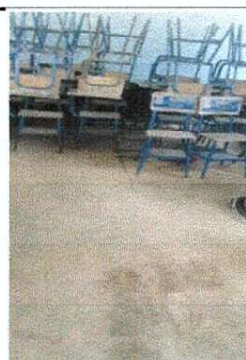
Foto 4: 1. Mejoramiento de piso ceramico en aula
