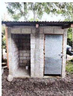
Foto 5: Mejoramiento y reparación de puertas de metal en servicio sanitario
