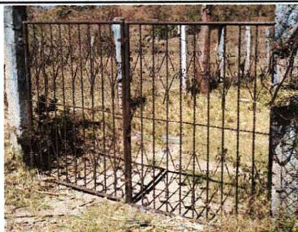
Foto 2: Mejoramiento, fabricación e instalación de portón.
