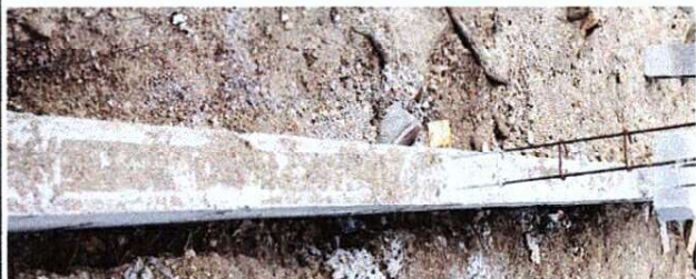
Foto 1: Mejoramiento y reparación de muro perimetral de block con tubo y malla galvanizada
