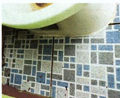
Foto 3: Mejoramiento de piso antideslizante en servicio sanitario
