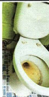
Foto 4: Mejoramiento y reparación de servicio sanitario
