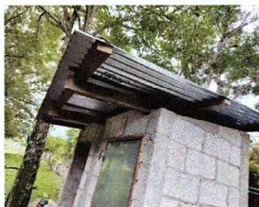
Foto 6: Sustitución de estructura de madera por metal
