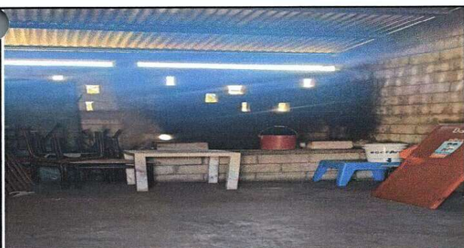
Foto 5: Remodelación de cocina
