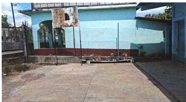
Foto 3: Reparación de muro, lado norte
