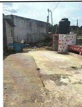
Foto 4: Reparación de piso de torta
