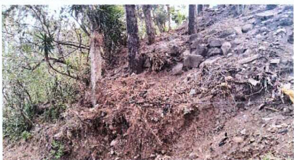
Mejoramiento y reparación de muro perimetral de contención
