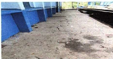
Foto1: reparacion de planchas de concreto. modulo 1 aulas de primero y sexto
