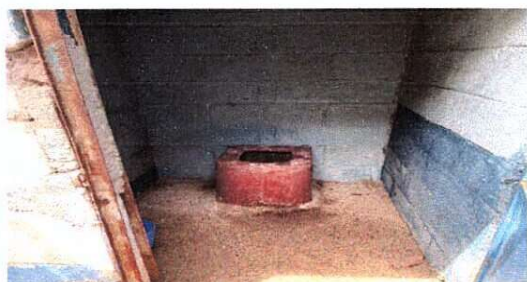
Foto 3: sustitucion de inodoros
