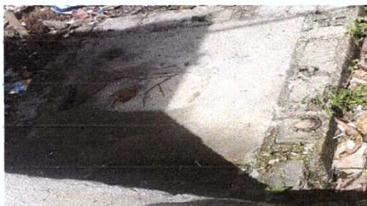
Foto 5: limpieza y mantenimiento de fosas
