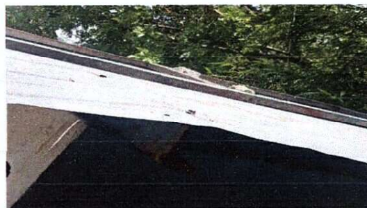
Foto 4: sustitucion de canales de bajadas de aguas pluviales
