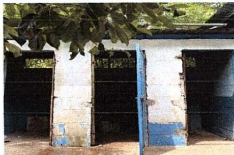
Foto 2: reparacion de cubierta de lamina, estructura de techo, puertas, piso, red de drenaje, sustitucion de inodoro y repello de paredes.
