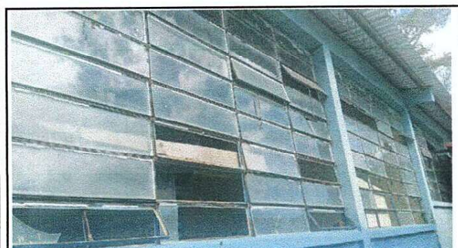
Sustitución de Vidrios
