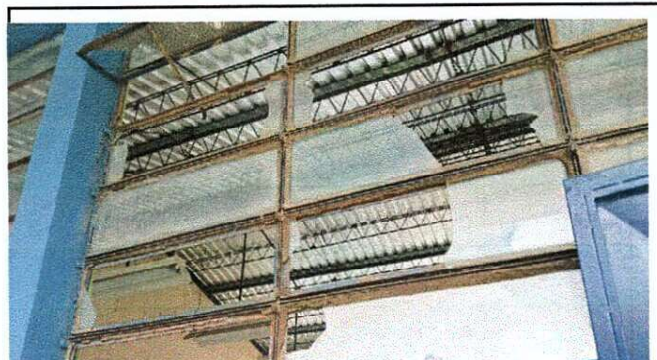
Sustitución de Vidrios
