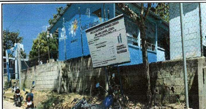
Reparacion de muro Perimetral
