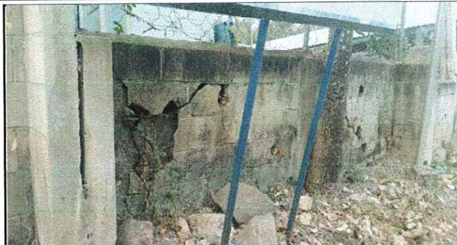
Reparacion de muro Perimetral
