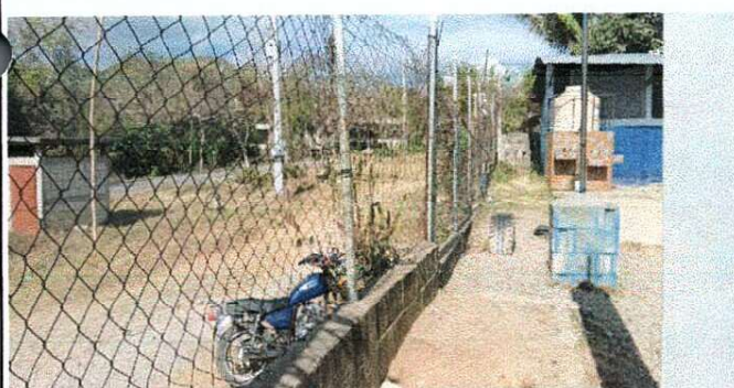
Sustitución de Malla y tubos galvanizados
