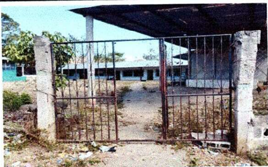
Foto 3: Mejoramiento, fabricación e instalación de porton principal
