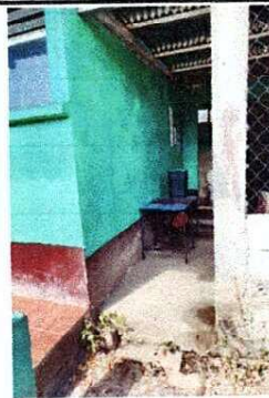
Foto 2: Fabricacion e instalación de puerta en cocina
