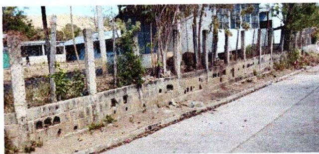
Foto 6: Reparacion de grietas en muro mas cernido de muro
