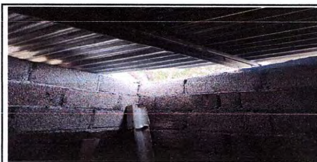
Foto 5: Mejoramiento de techo en cocina.
