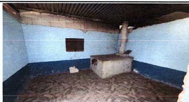
Foto 1: Mejoramiento y sustitución de estufa rural completa en cocina
