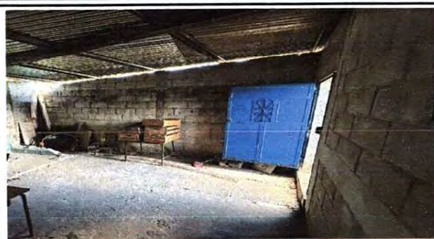
Foto 8: Mejoramiento de base de concreto para contrapiso en cocina.
