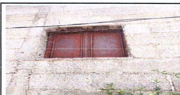
Foto 6: Fabricación e instalación de ventana de metal en cocina.
