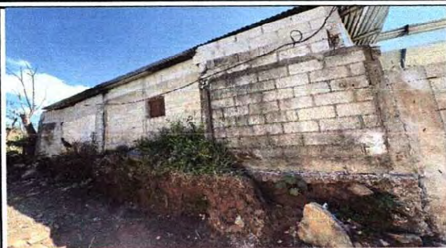
Foto 7: Mejoramiento de muro perimetral que sirve como base para la cocina. Se observa que la cimentación es superficial, lo que hace que este muro sea muy inestable.
