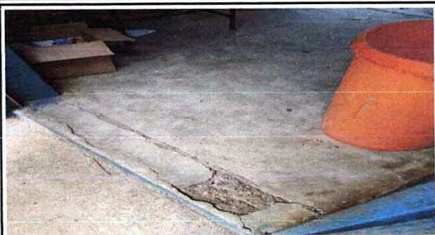
Foto 13. Mejoramiento e instalación de piso cerámico antideslizante para tráfico intenso para modulo 2, incluye picado y remoción de capa mala en torta de concreto existente.
