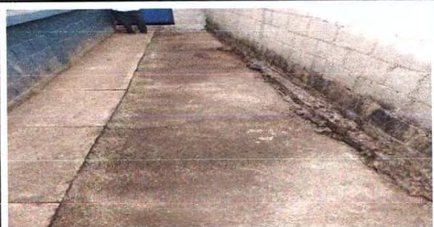
Foto 10: Mejoramiento de drenaje de agua pluvial más reposadera.
