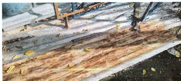
Foto 2: Mejoramiento de lámina por lamina troquelada aluzinc calibre 26
