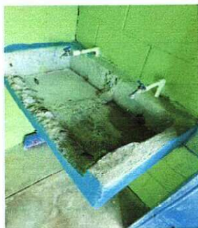
Foto 5: Mejoramiento de lavamanos
