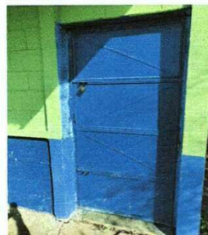
Foto 6: Reparación de puerta, mantenimiento a estructura (lijado o cepillado, aplicación de pintura, incluye chapa).
