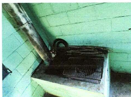
Foto 3: Sustitución de estufa rural
