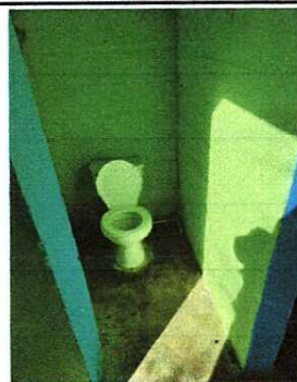
Foto 4: Mejoramiento y reparación de servicio sanitario, fabricación e instalación de puerta, mas azulejo y piso antideslizante,
