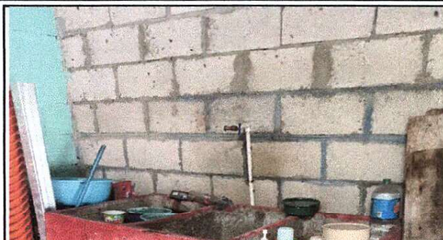
Foto 2: sustitucion de tubería principal y sustitucion de llave de chorro
