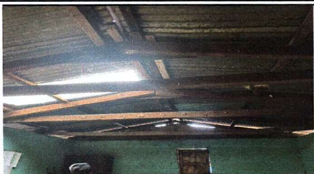
Foto 1. Cubierta de lamina y estructura de techo.
