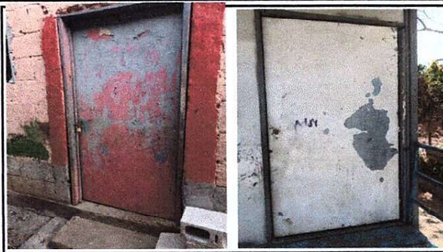
Foto 2: Sustitución puertas 1 y 2
