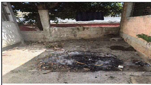
Foto 4: Reparación de de plancha de concreto de patio
