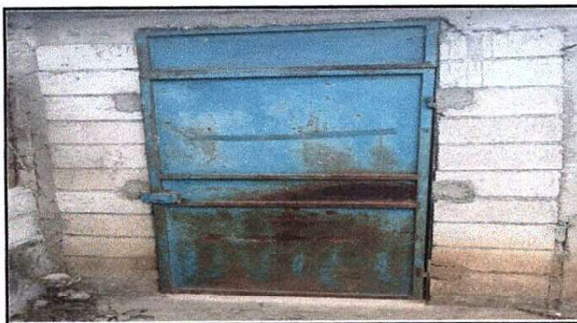
Foto 3: Sustitucion de porton de metal
