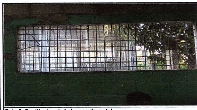
Foto 5: Sustitucion de balcones de metal.
