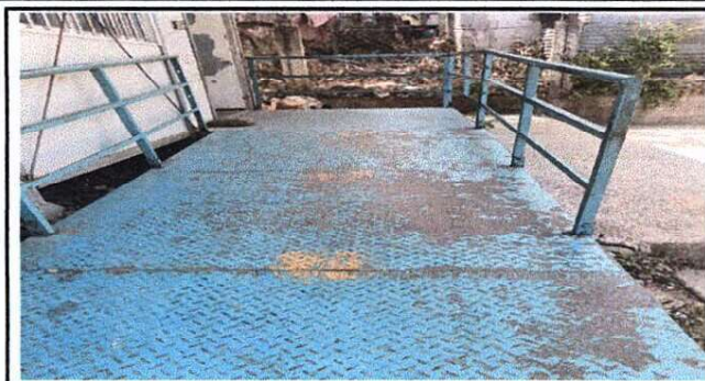
Foto 1: Mantenimiento a Barandas de metal.
