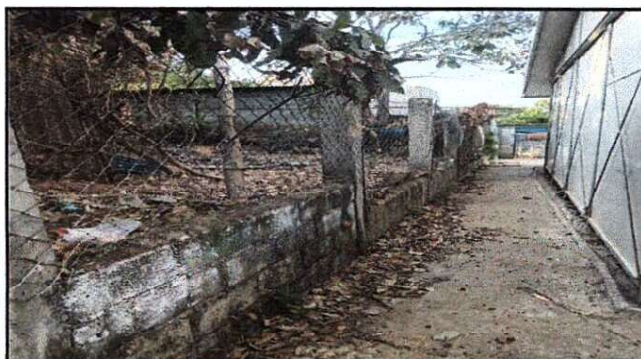
Foto 3: reparacion muros perimetrales
