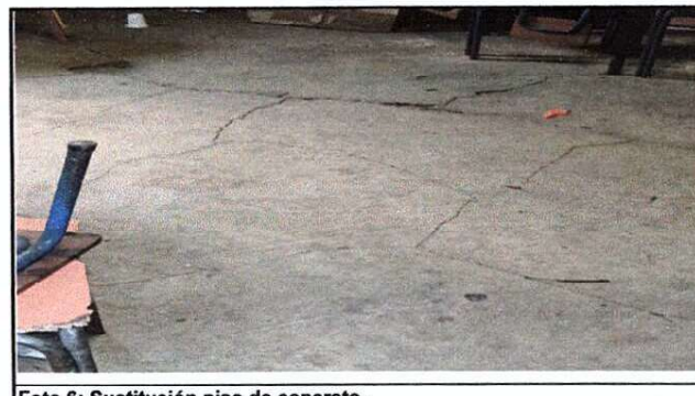
Foto 6: Sustitución piso de concreto.
