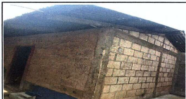
Foto 5: Repello muros exteriores de aula.
