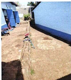
Foto 1: Mejormiento de baranda frente a modulo
