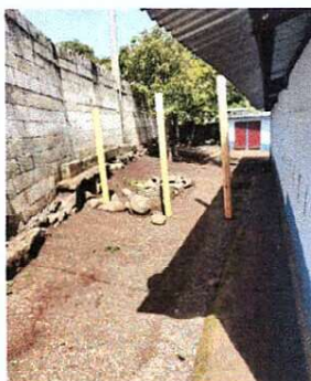
Foto 3: MEJORAMIENTO DE CUNETETA DE CONCRETO Y LOSA DE PATIO
