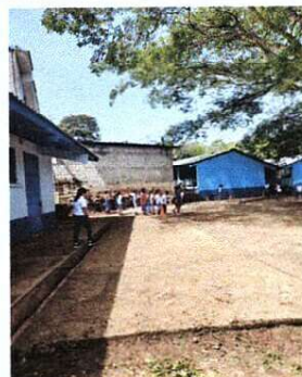
Foto 2: MEJORAMIENTO DE ESTRUCTURA DE TECHO Y LÁMINA TROQUELADA ALUZINC
