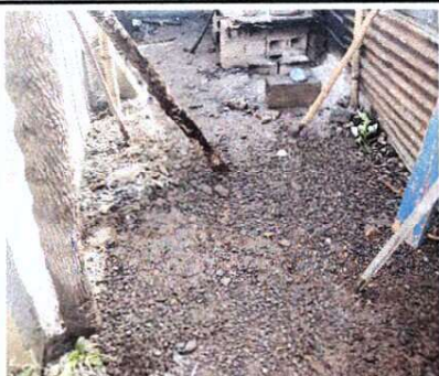
Foto 5: MEJORAMIENTO DE LOSA DE CONCRETO EN COCINA
