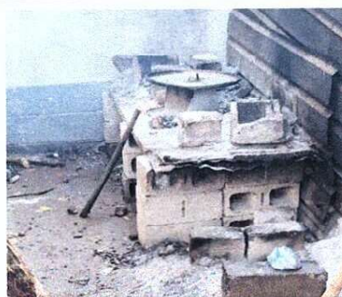
Foto 4: REPARACIÓN DE ESTUFA RURAL CON PARRILLA DE DE METAL
