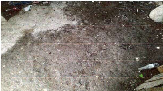
SUSTITUCIÓN DE TORTA DE TIERRA POR TORTA DE CEMENTO
