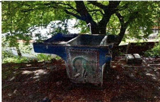
SUSTITUCIÓN Y READECUACIÓN DE PILA DE CEMENTO
