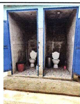
Foto 4: Área de Baños, remozamiento de puertas, sustitución de pared de block, sustitución de puerta, sustitución de tazas de inodoro para niño y adulto, lavamanos, remozamiento de instalación de agua potable.
