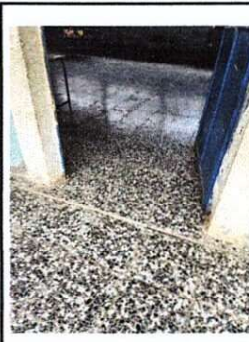
Foto 2: Área de Aulas, remozamiento de piso de granito, sustitución de piso cerámico corredor, remozamiento de puertas y portón, tapado de luz entre techo y pared, remozamiento de canal y sustitución de tubería de
