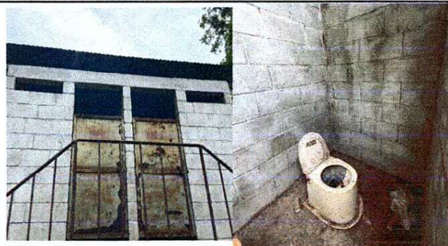
AMPLIACIÓN Y REMODELACIÓN DE SERVICIOS SANITARIOS, SUSTITUCIÓN DE INODOROS, SUSTITUCIÓN DE PUERTAS, SUSTITUCIÓN DE LAMINA POR LAMINA TROQUELADA ESTRUCTURA METÁLICA Y SUSTITUCIÓN DE TORTA DE CONCRETO.
