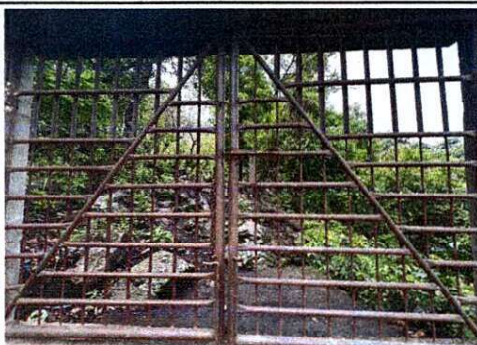
MANTENIMIENTO A PORTÓN
