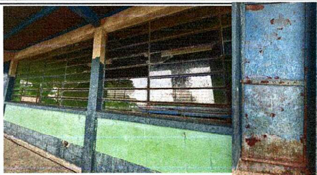
INSTALACIÓN DE VENTANAS DE PVC, REPARACIÓN DE VIDRIOS EN MAL ESTADO Y REMOZAMIENTO DE PUERTAS.
