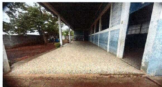
SUSTITUCIÓN DE PISO DE GRANITO POR PISO CERÁMICO EN CORREDOR Y DIRECCIÓN
