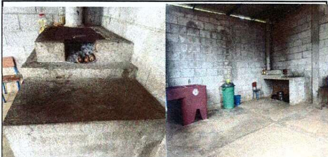
SUSTITUCIÓN DE PLANCHA RURAL Y FABRICACIÓN DE MESA CEMENTO Y COLOCACIÓN DE AZULEJO
