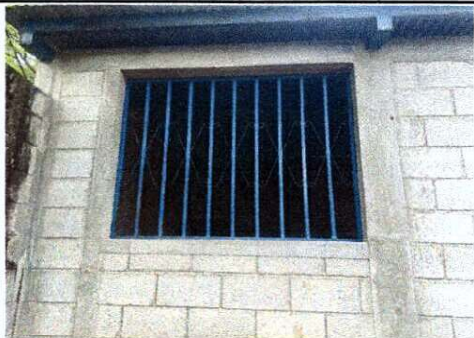
COLOCACIÓN DE VENTANAS PVC
