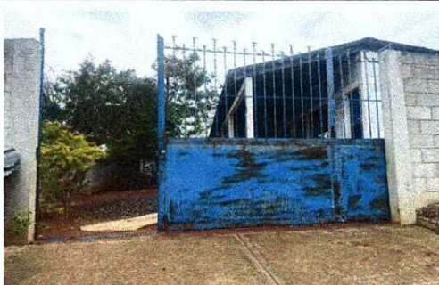
MANTENIMIENTO A PORTON Y FABRICACIÓN DE PUERTA DE ACCESO PRINCIPAL
