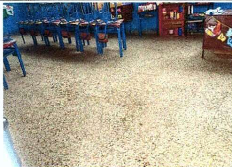
SUSTITUCIÓN DE PISO DE GRANITO POR PISO CERAMICO EN AULAS
