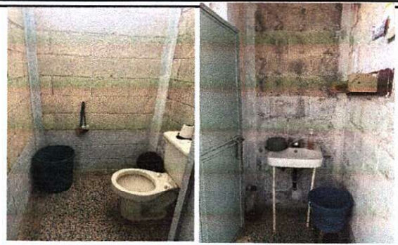
SERVICIOS SANITARIOS: COLOCACIÓN DE AZULEJO Y SUSTITUCIÓN DE INODORO Y LAVAMANOS
