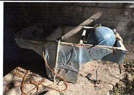
REPARACIÓN Y READECUACIÓN DE PILA
