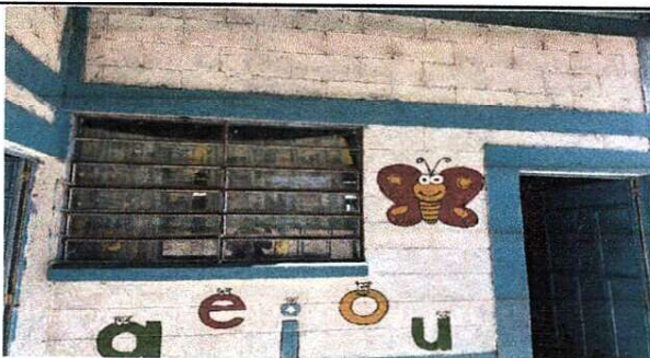
INSTALACIÓN DE VENTANAS PVC
