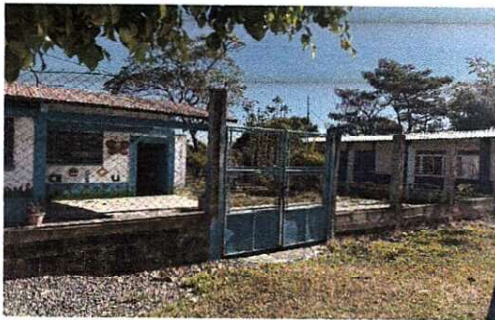
MANTENIMIENTO DE PORTÓN Y MALLA
