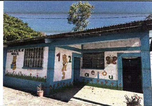
PINTURA EN MUROS INTERIORES Y EXTERIORES
