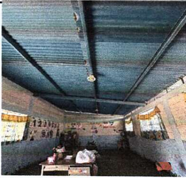
TECHO: SUSTITUCIÓN DE ESTRUCTURA METÁLICA Y LAMINA POR LÁMINA TROQUELADA.
