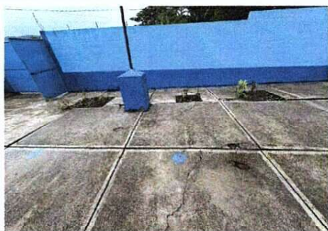
Foto 3: Muros y patios, remozamiento teja proyectora en muros, proyección de portón arriba con lamina en dos aguas, colocación de 4 columnas para reforzar muro perimetral, sustitución de planchas de concreto en patio en mal estado.
