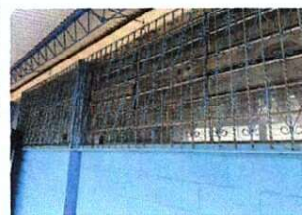
Foto 2: Área de Aulas, remozamiento de balcones (pintura), cambio de vidrio rotos, remozamiento de puertas, pintura lavable en todas las paredes.
