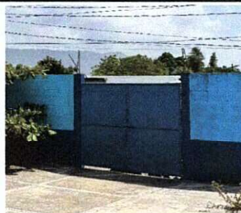
Colocación de techo a porton de entrada principal
