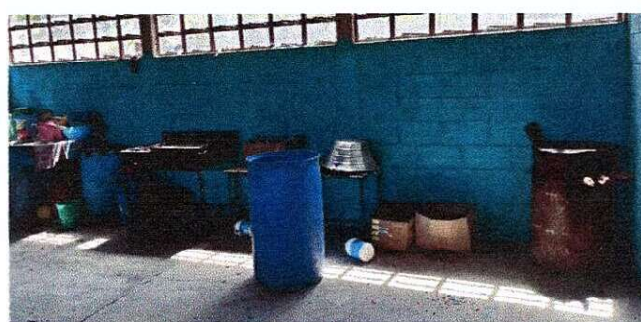
Foto 4: EDIFICACION DE COCINA DE LEÑA, DE MESA DE CONCRETO, INSTALACION DE DRENAJE PARA PILA YA EXISTENTE
