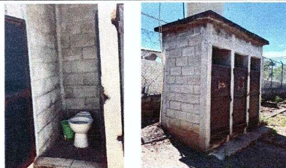
Foto 6: SUSTITUCIÓN DE SANITARIOS Y ACCESORIOS, MANTENIMIENTO DE PUERTA Y PINTURA DE INTERIOR Y EXTERIOR DE MODULO DE SANITARIOS
