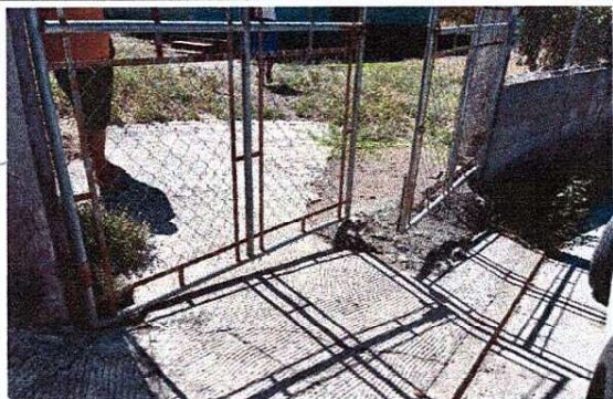
Foto1: MANTENIMIENTO, PINTURA, DE PORTON DE INGRESO PRINCIPAL Y MEJORAMIENTO DE TORTA CEMENTO DE INGRESO PRICIPAL
